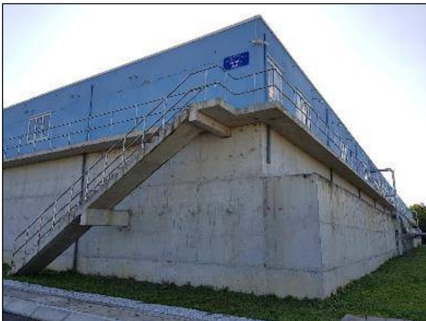
Hệ thống xử lý nước thải Hoà Xuân Air Blower ARS200 75KW x 6 units (2018)
