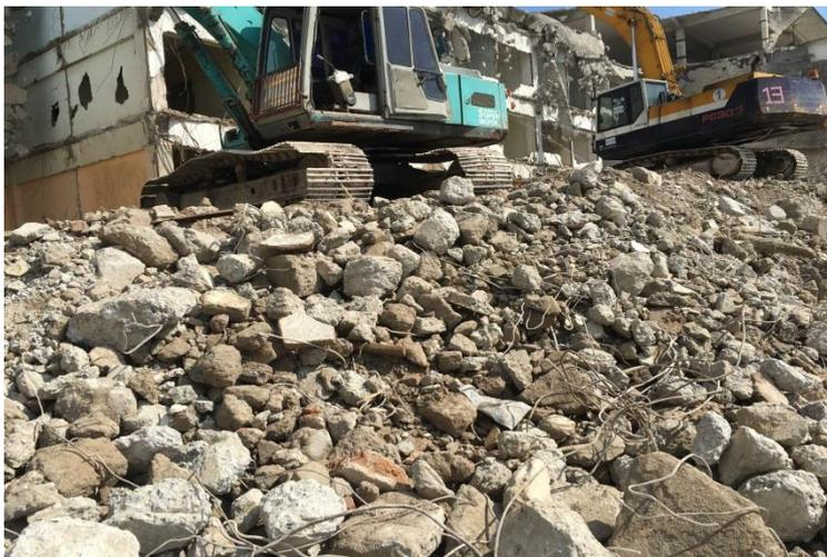
埋戻し材として引き取られるコンクリート廢材
